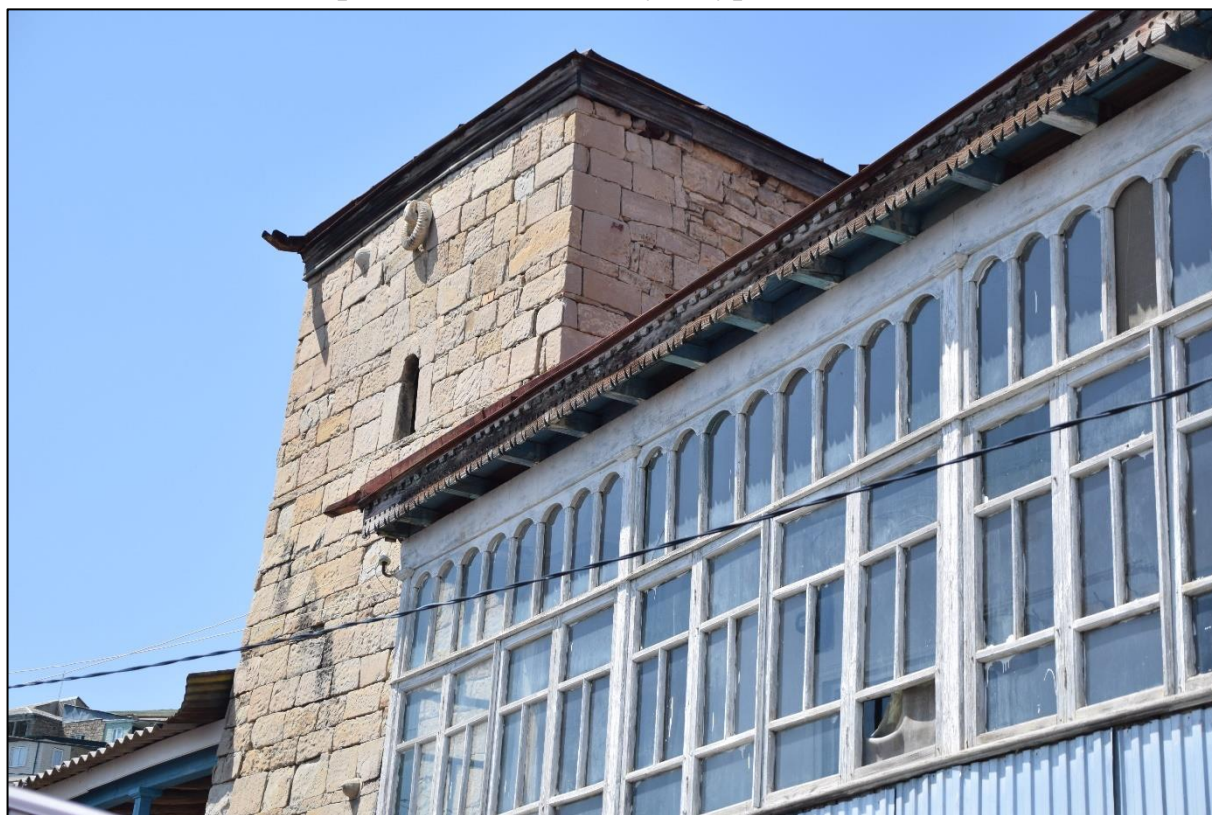
Фото 1. Общий вид здания, вид на главный фасад.
