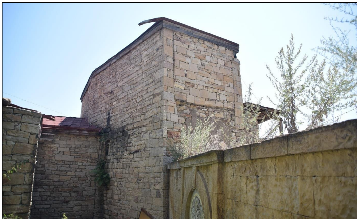
Фото 2. Общий вид здания, вид на фасад с тыльной стороны. (Фото предоставлены Агентством по охране объектов культурного наследия Республики Дагестан. Дата снимка 02.08.2022 г.)
